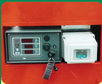
QUADRO AVVIAMENTO E DISPOSITIVO NO STRESS
