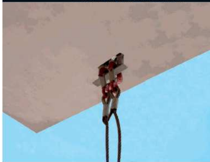
Anclaje bajo alero colocado
