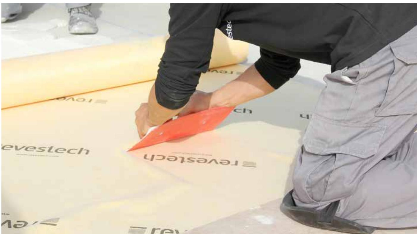
2. Presionar fuerte la lámina sobre el soporte con ayuda de la llana, asegurándose de eliminar todas las posibles bolsas de aire que se hayan generado. **ATENCIÓN:** una vez instalada la lámina, se deberá comprobar que la lámina esté totalmente pegada al soporte.
