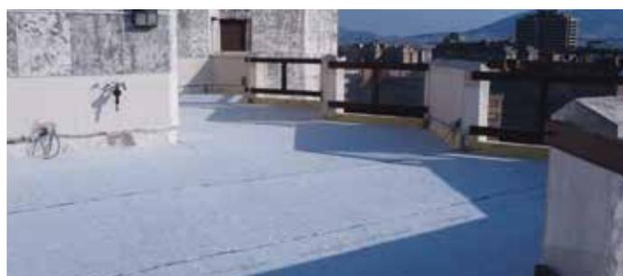
2. Sobre la lámina **DRY80**, instalar sin adherir (flotante) el geosintético tridimensional **ROOT**.
