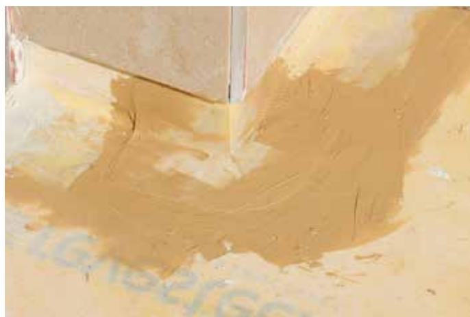
4. Colocar la pieza **CORNER OUT** y volver a aplicar adhesivo **SEAL PLUS** sobre la pieza haciendo un doble sellado.
