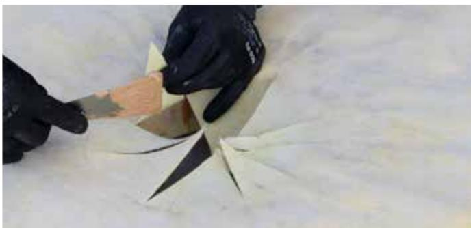
3. Poner lámina **DRY80** encima y cortar como en la imagen. Aplicar adhesivo **SEAL PLUS** en la unión de la lámina con el interior del sumidero.
