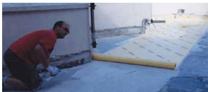
1. Impermeabilizar toda la zona, utilizando la lámina **DRY80**.
