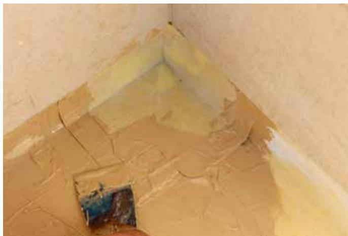
2. Colocar la pieza **CORNER IN** y volver a aplicar adhesivo **SEAL PLUS** sobre la pieza haciendo un doble sellado.
