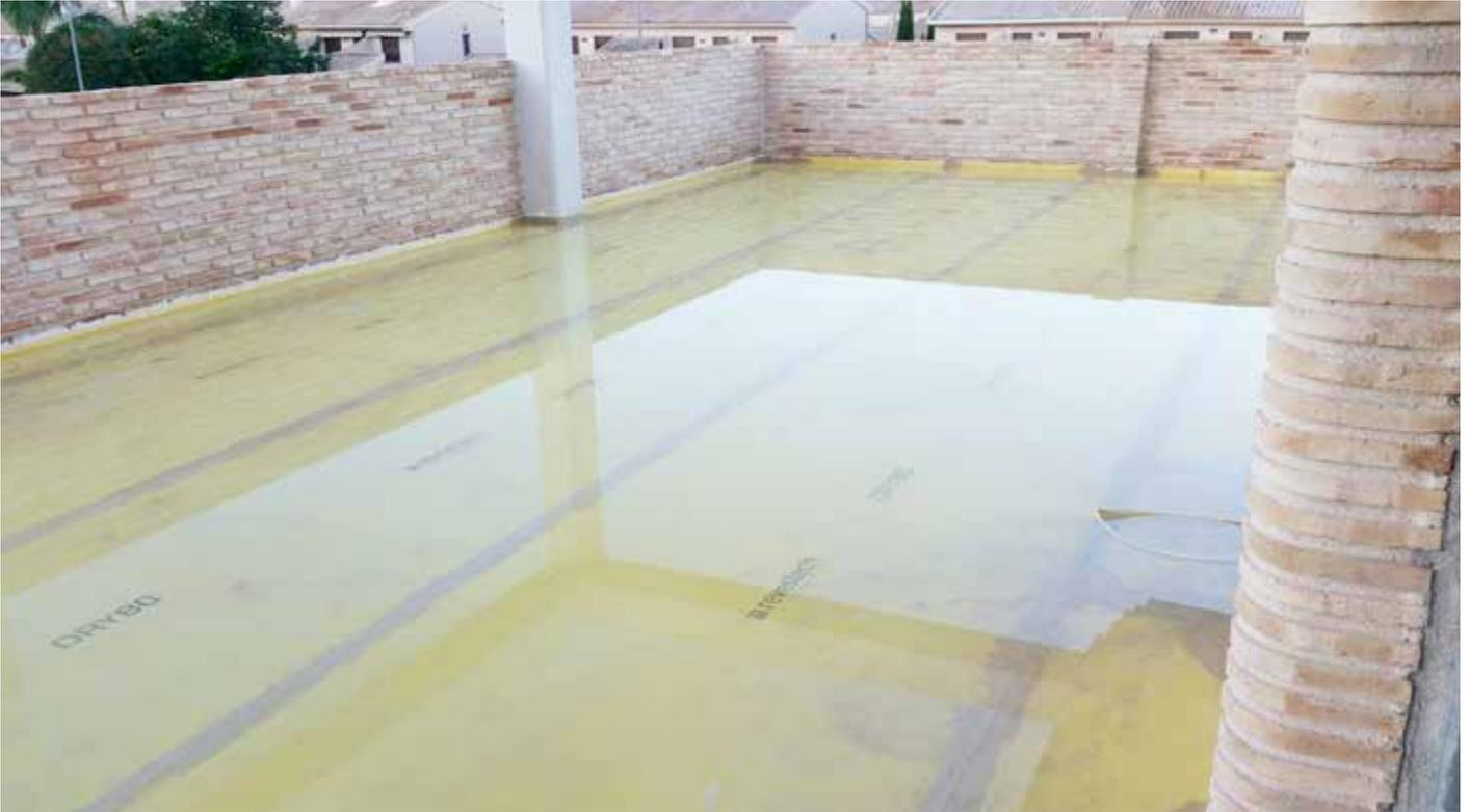
**5. OPCIONAL:** Una vez finalizada la instalación, con un tiempo de espera de 48 horas, se puede realizar una prueba de estanqueidad precisa.
