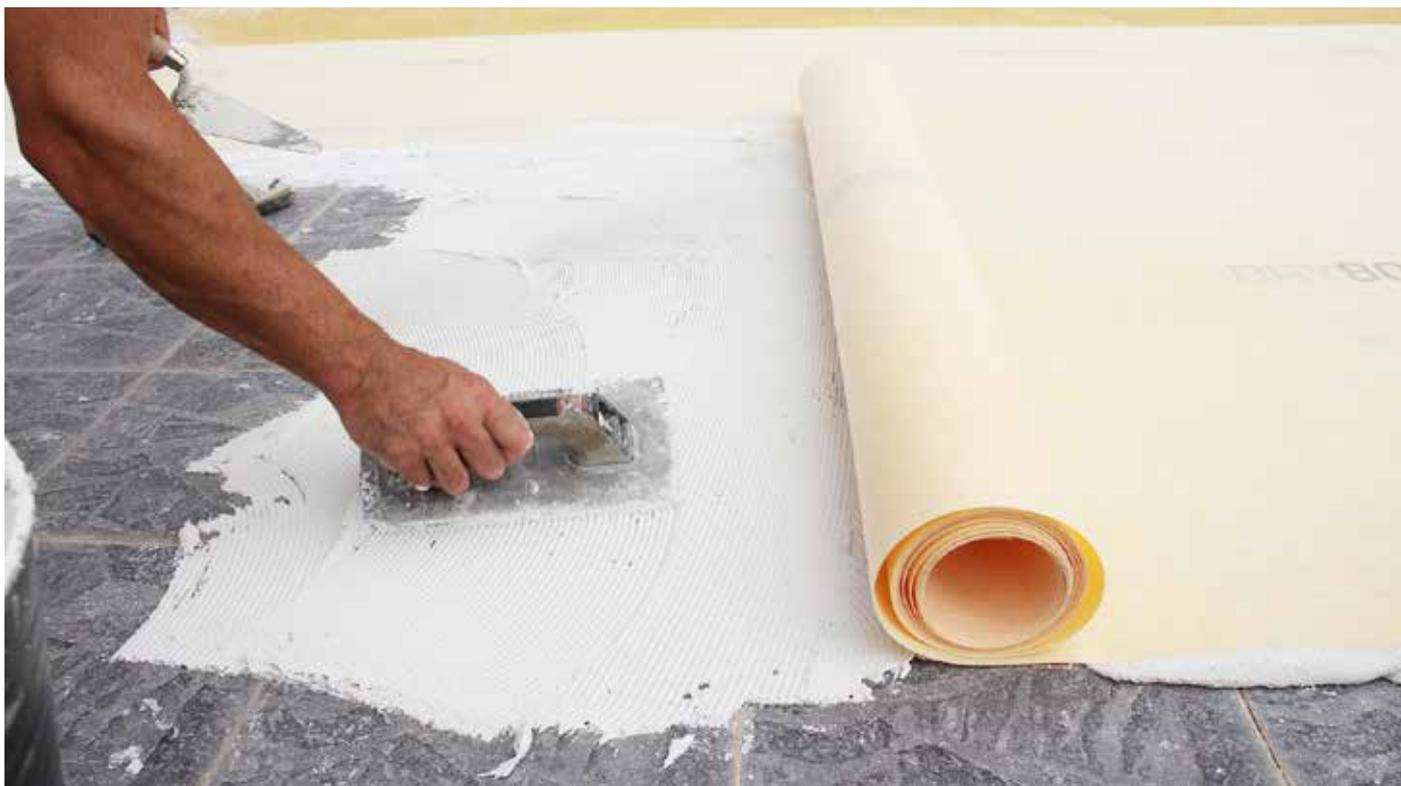
1. Comprobar la estabilidad del soporte y limpiar la superficie, a continuación aplicar cemento cola clase C2 con llana dentada. Aplicar el adhesivo en pequeños paños para evitar que se seque. En ningún caso instalar la lámina sobre un cemento cola semi fraguado.
