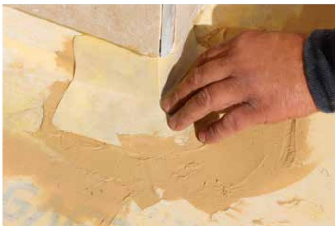
3. Una vez instalada la lámina **DRY80** aplicar adhesivo **SEAL PLUS** sobre la zona de esquina.
