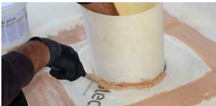
1. Introducir un corte de lámina **DRY80** en forma de tubo dentro del sumidero y sellar con adhesivo **SEAL PLUS**.
