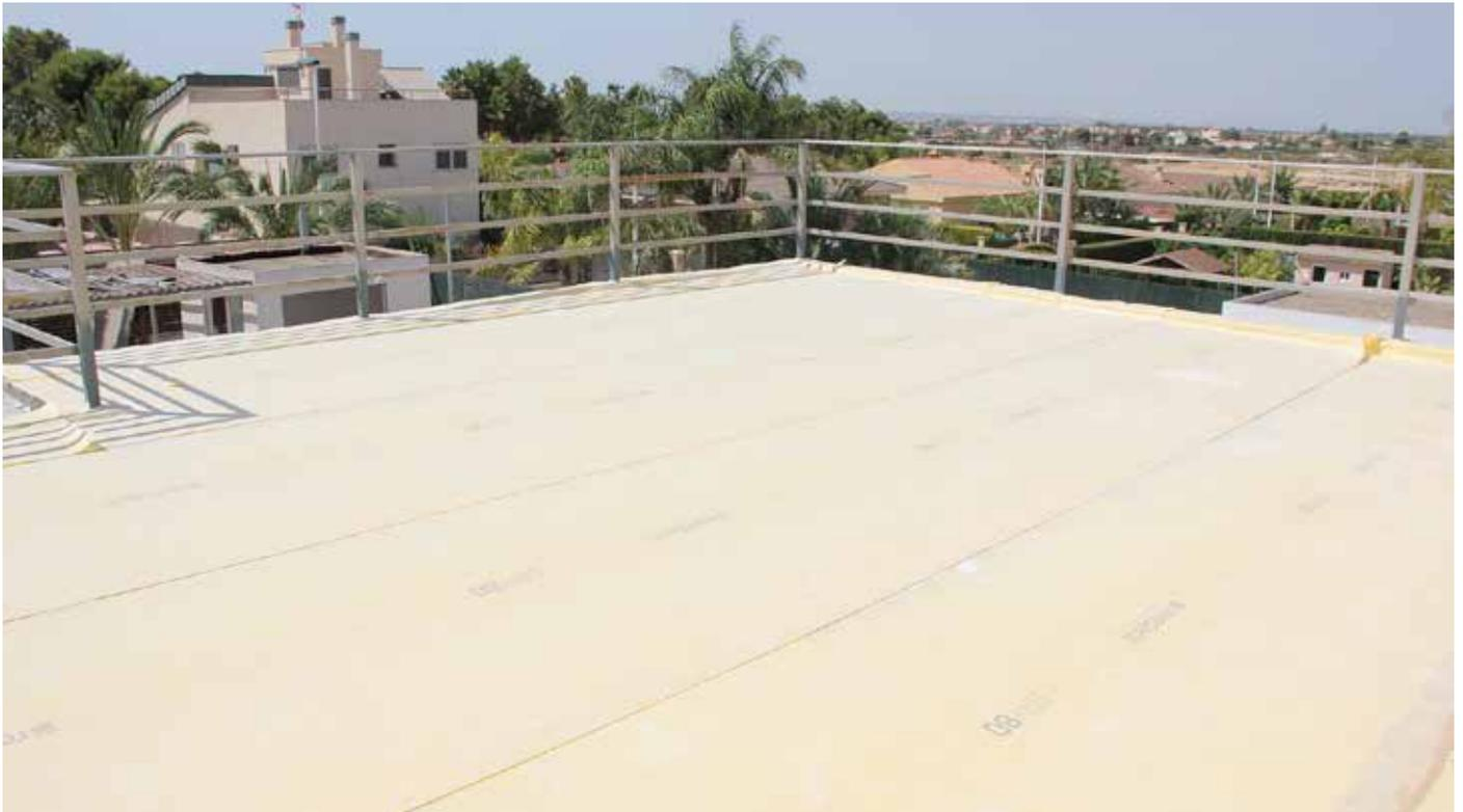
3. Instalar las láminas siempre a favor de la pendiente, partiendo del sumidero hacia arriba. Dejar un solape entre láminas mínimo de 10 cm.
