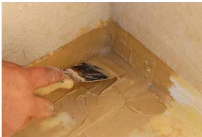
1. Una vez instalada la lámina **DRY80** aplicar adhesivo **SEAL PLUS** sobre la zona de rincón.
