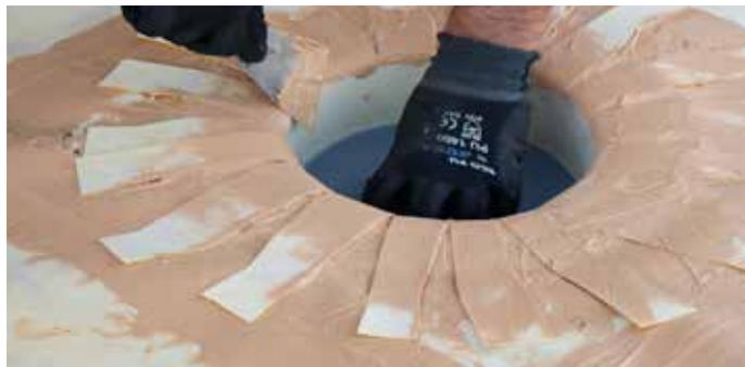
2. Cortar el tubo de lámina como en la imagen.
