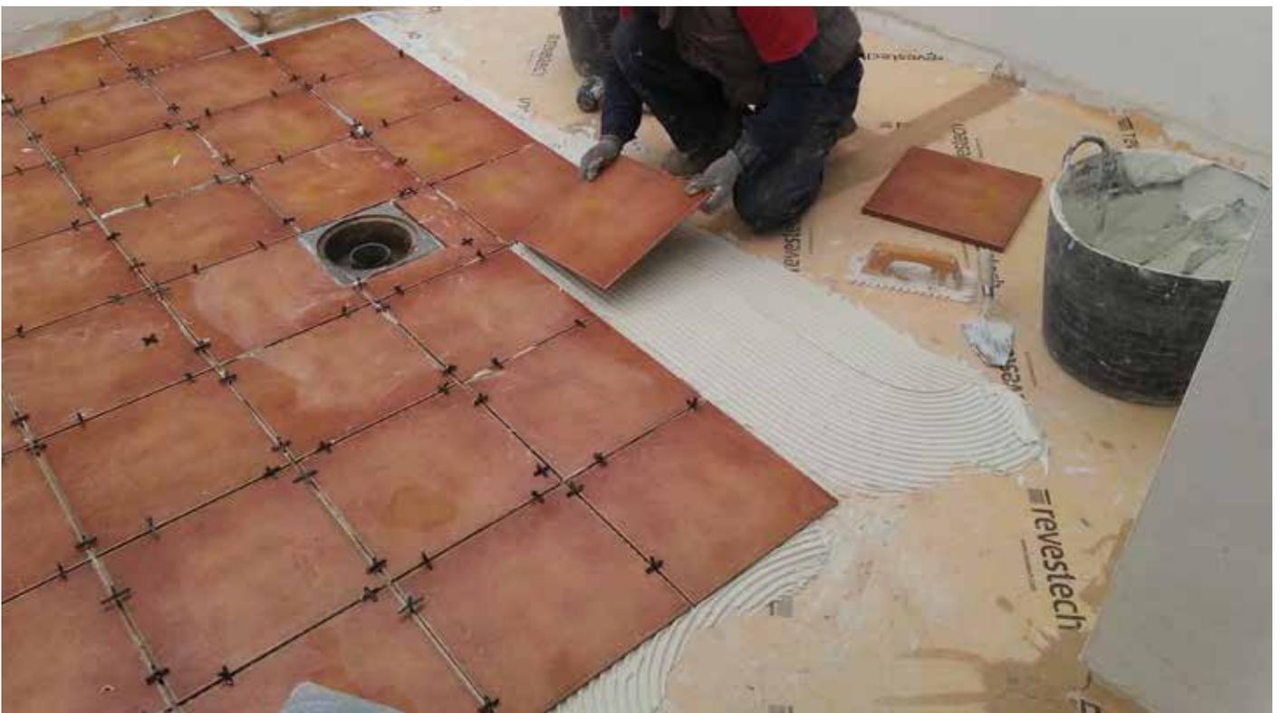
**6.** Colocar el pavimento directamente con cemento cola clase C2 y fijar el rodapié. Trabajo terminado de manera rápida, fácil y con garantía de calidad.
