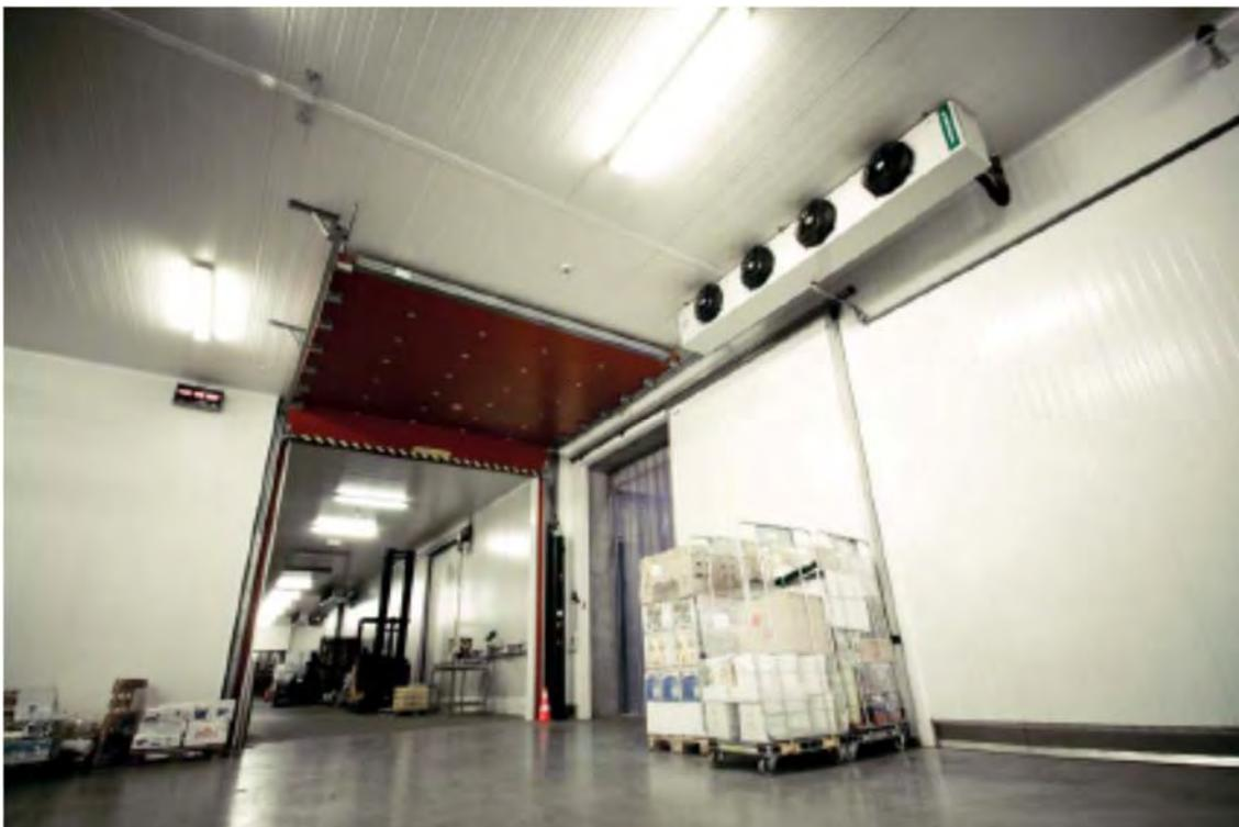
La puerta cortafuegos Seccional GIBIL cumple con los criterios de estabilidad y aislamiento térmico resistente a las llamas de acuerdo con la Norma NBN 713,020 de resistencia al fuego y certificado ATG.
