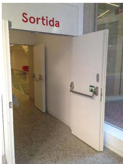
Las puertas cortafuegos Mecosa cumplen con la normativa vigente y para ello certificamos mediante ensayos en laboratorios oficiales en cada una de sus diferentes versiones, su aplicación está legislada en las diferentes ordenanzas de prevención de incendios NORMA UNE 23802 (NBE CPI/96), y UNE EN 1634-1
