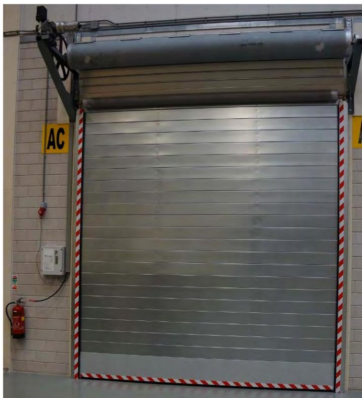
El funcionamiento de la puerta en semiautomático o automático consta de motor, cuadro de control electrónico, pulsadores de apertura, cierre, fotocélula y todos los elementos necesarios para una instalación completa.
