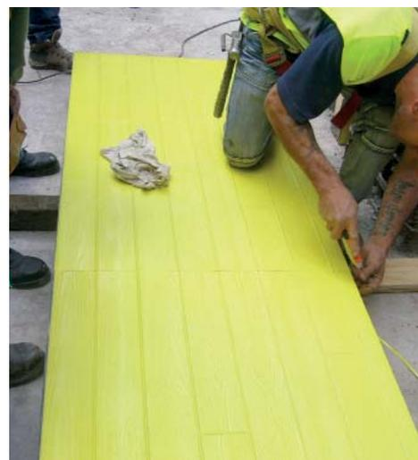
3.- Para la fijación del **LHV Formliner** se pueden utilizar diferentes técnicas.
