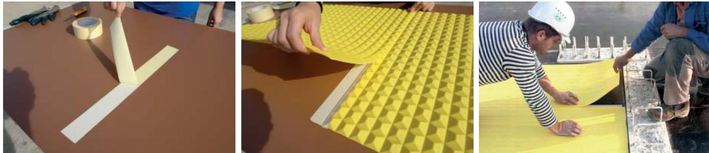
**4.-** Retirada del **LHV Formliner**. Se realiza de forma sencilla, basta con tirar de ella desde cualquier extremo. En caso de quedar restos de cola se puede utilizar disolvente o similar para la limpieza del panel de encofrar.
