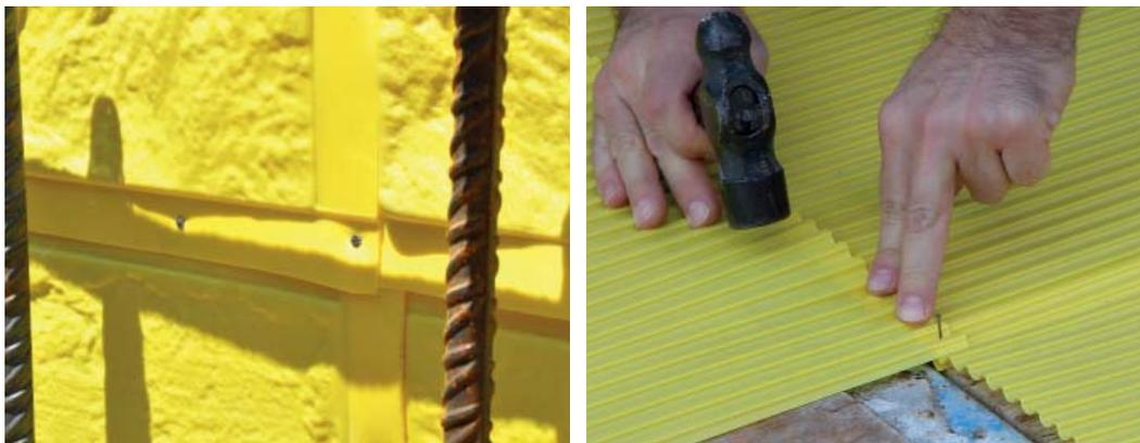
**3.3.-** Fijación mediante precinto a doble cara, según modelos. Se aplica un precinto a doble sobre el perímetro del **LHV Formliner**, y franjas cada 20/30 cm si vemos que es necesario. Se retira el papel protector del precinto y se procede a la fijación de la lámina **LHV Formliner** sobre el panel de encofrar.
