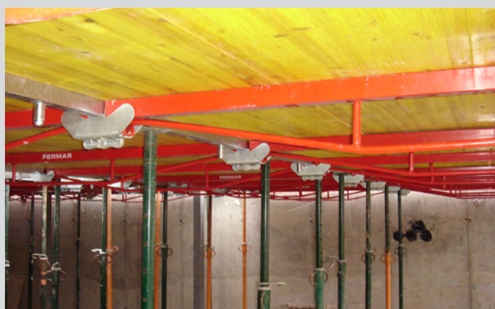
Unión de los cuatro elementos / Union des quatre elements / Four elements union
