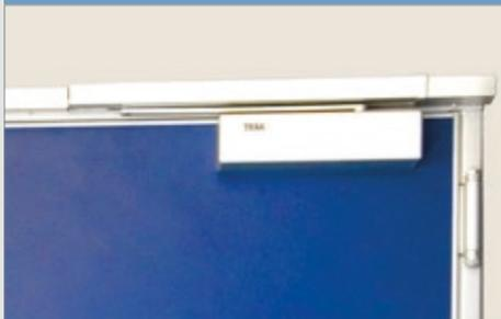
Accesorio instalado en el marco y en la parte superior de la hoja, que controla y asegura el cierre de la misma. Dispone de marcado CE y ofrece varios tipos de instalación y fuerza. La elección del mismo debe hacerse en función del tamaño y peso de la puerta, así como del nivel de uso del conjunto: moderado, frecuente o intensivo.
