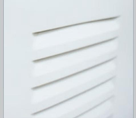
Las puertas Multusos con ventilación presentan unas aberturas horizontales que permiten la aireación de los recintos. Estas caladas no permiten el paso del agua pero si el paso del aire.
