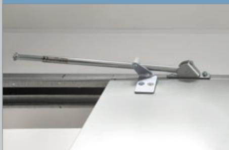
Mecanismo instalado en el marco y en la parte superior de una puerta de dos hojas, que controla y asegura el cierre de la hoja activa sobre la hoja inactiva. Puede ser de guía o de brazo.
