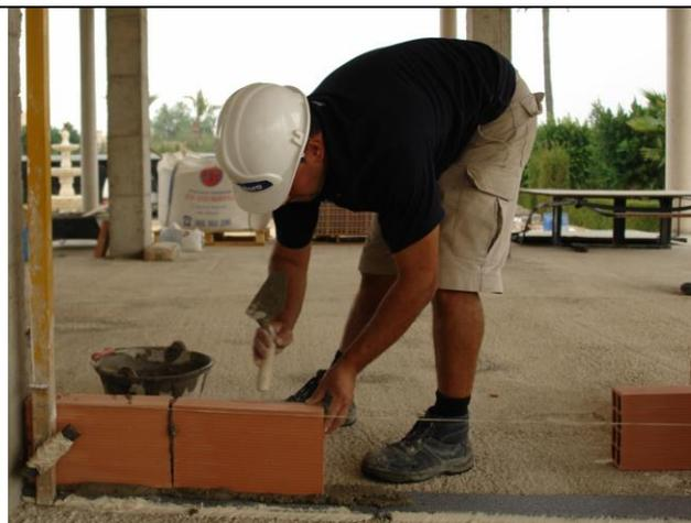
3- Levantar la hoja de ladrillos sobre la tira fijada al forjado. Siempre que sea la tira de EEPS 30 mm más grande que la hoja de ladrillo, así la pellada de cemento no tocará el forjado y será realmente un tabique flotante.
